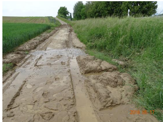
Abb. 2: Abgelagertes Bodenmaterial auf Feldweg in Schallbach im Mai 2018 (Foto: Patrick Blau)
