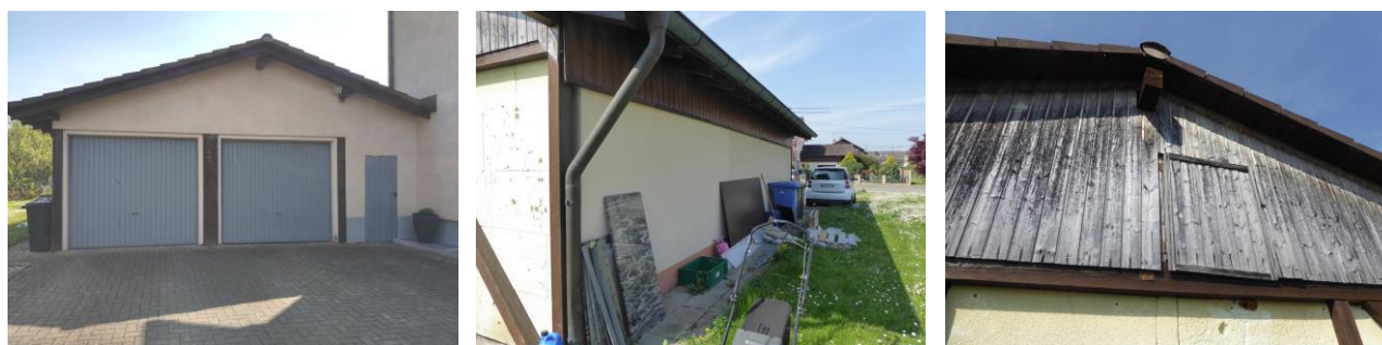
Abbildung 15: Abzureißendes Gebäude (Garage mit angrenzendem Schuppen) ohne Hinweise auf eine Nutzung durch Fledermäuse (Fotos: Kunz GaLaPlan)
