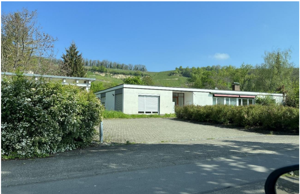
Gebäudebestand im Plangebiet
