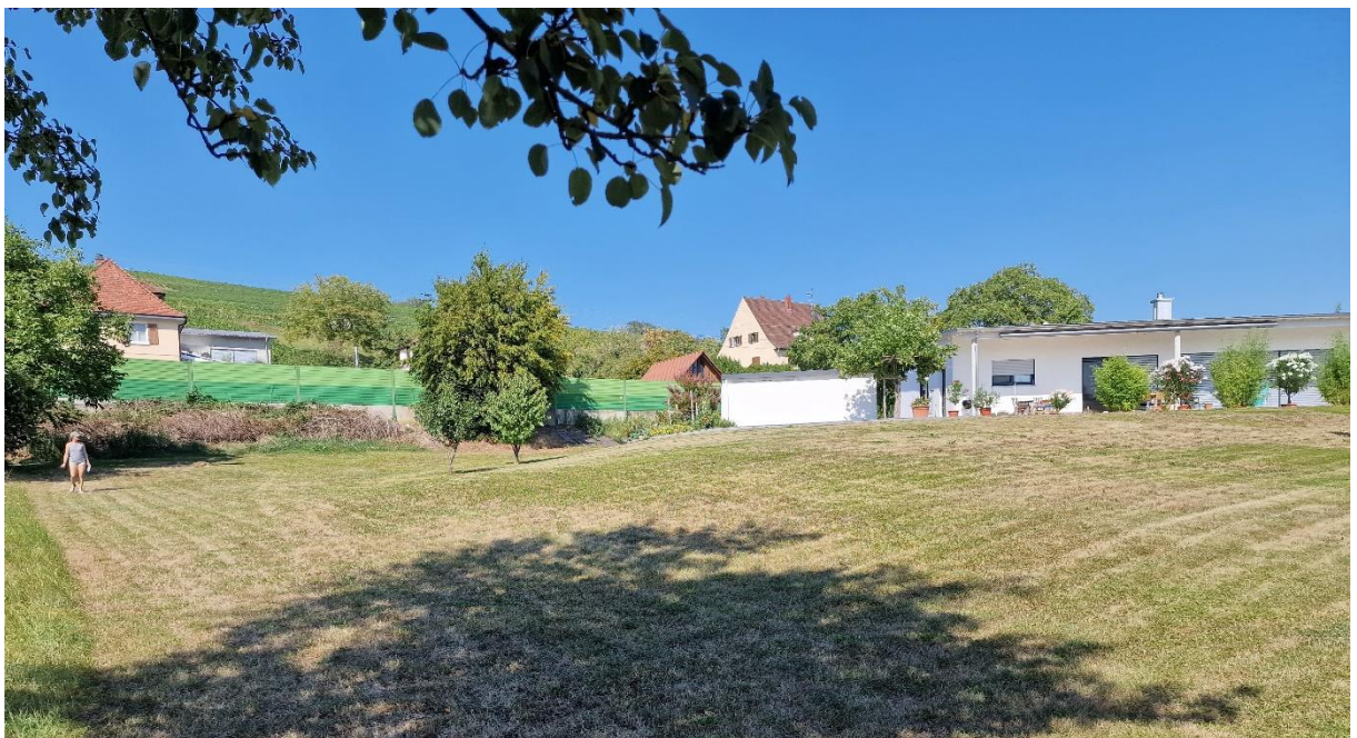
Abbildung 6: Die Bebauung erfolgt in der linken Bildhälfte vor der Lärmschutzwand
